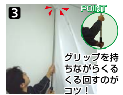
天井に到達したらバーを回転させ、定着するまで微調整します。
